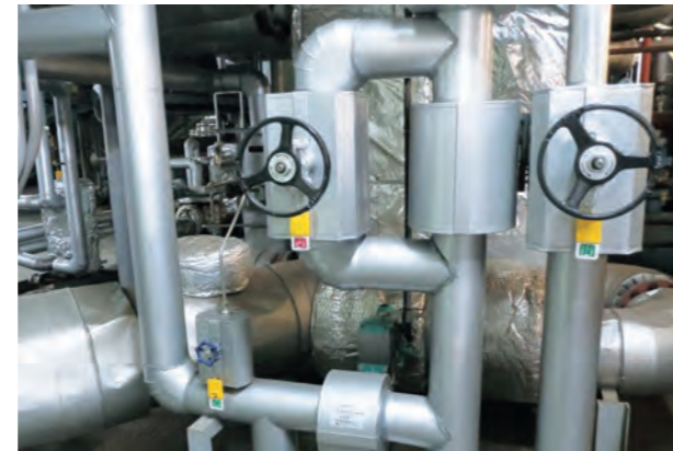
蒸気配管の保温強化実施例
