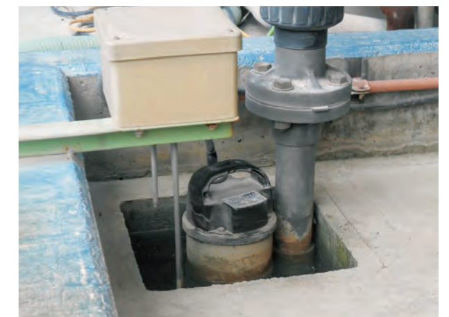
防液堤内の排水ピット
