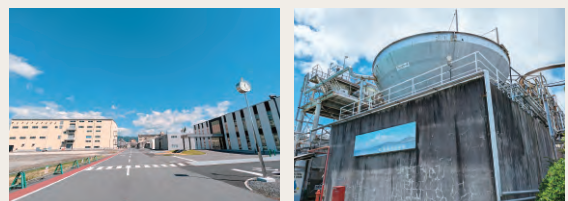
工場全景と排水処理施設
