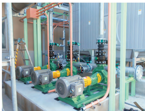
福島第一工場の製造設備
