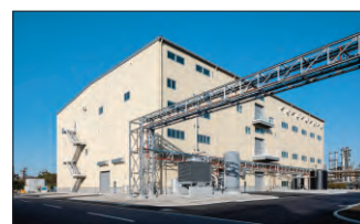
電子セラミック材料工場の外観(徳山工場)
