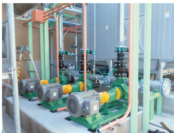
福島第一工場の製造設備
