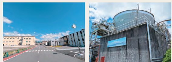
工場全景と排水処理施設
