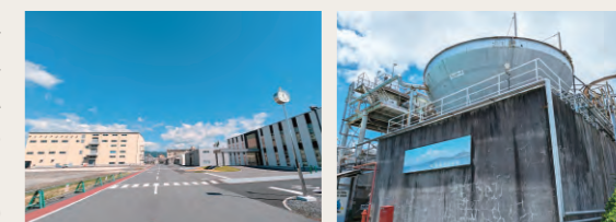
工場全景と排水処理施設
