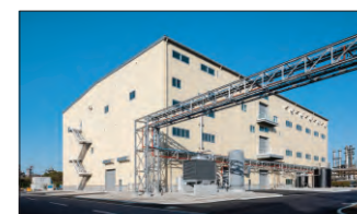
電子セラミック材料工場の外観(徳山工場)
