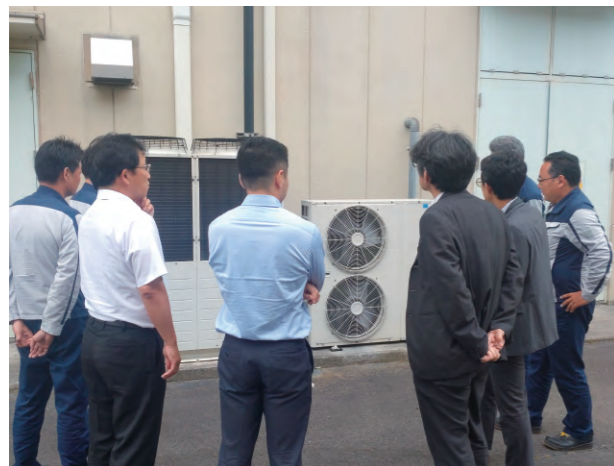
事務所前エアコン室外機見学の様子
