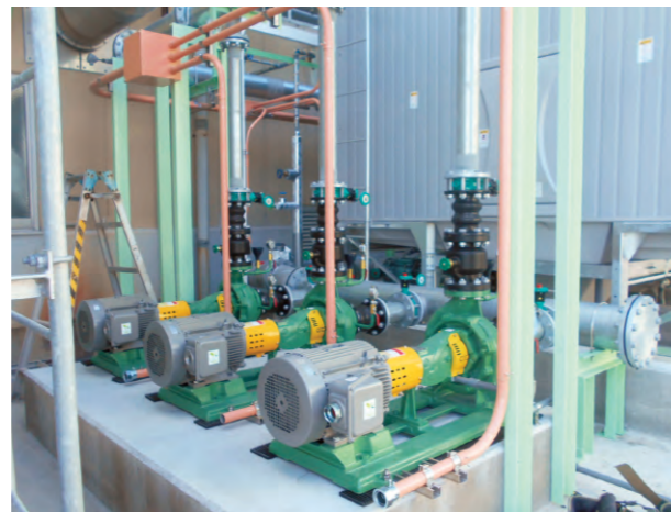
福島第一工場の製造設備
