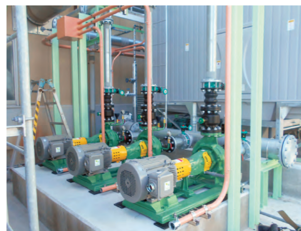
福島第一工場の製造設備
