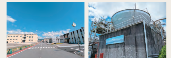
工場全景と排水処理施設
