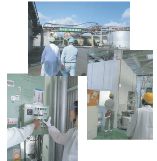
5月から6月にかけて、RCワーキンググループによる部門RC監査を実施します。（監査後の現地確認の様子）
